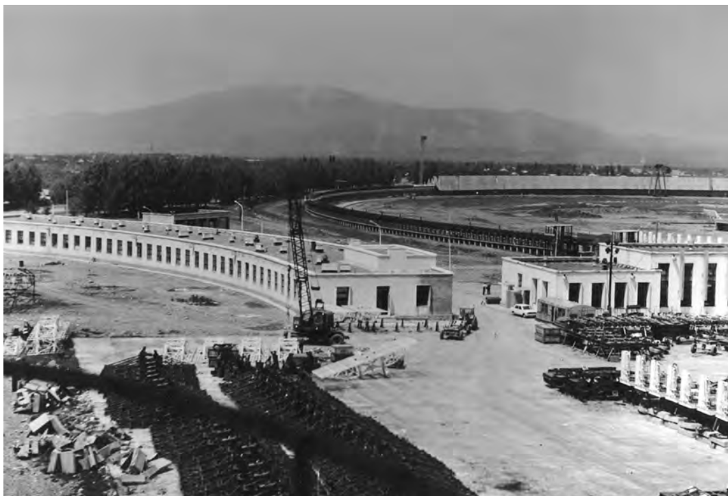
Общий вид стройки РАТАН-600 и других строений, 1970-е гг.
