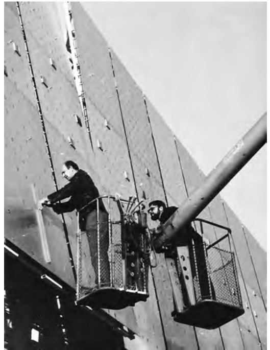
Закрепляют регулировочные винты для корректировки формы поверхности. Ю.Н. Парийский и ведущий конструктор А.И. Копылов. 1973 г.
